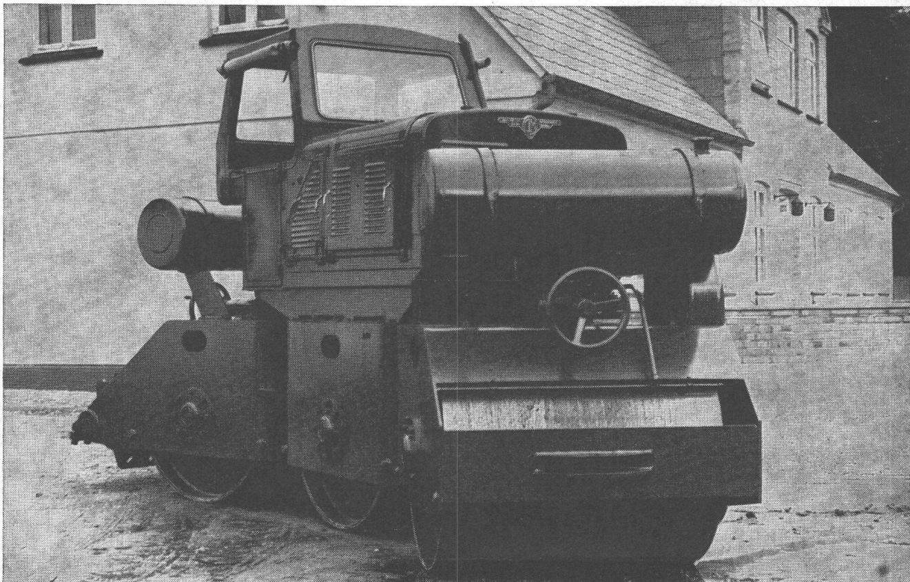
Poids de service uniformément réparti. Chaque cylindre agit indépendamment. Braquage de 30° permet un rayon intérieur de 3 m seulement. 5 positions différentes de travail. Moteur Ford-Diesel, 4 cylindres, 40,6 CV à 1600 t/min, refroidi à l'eau, avec démarreur électrique.
