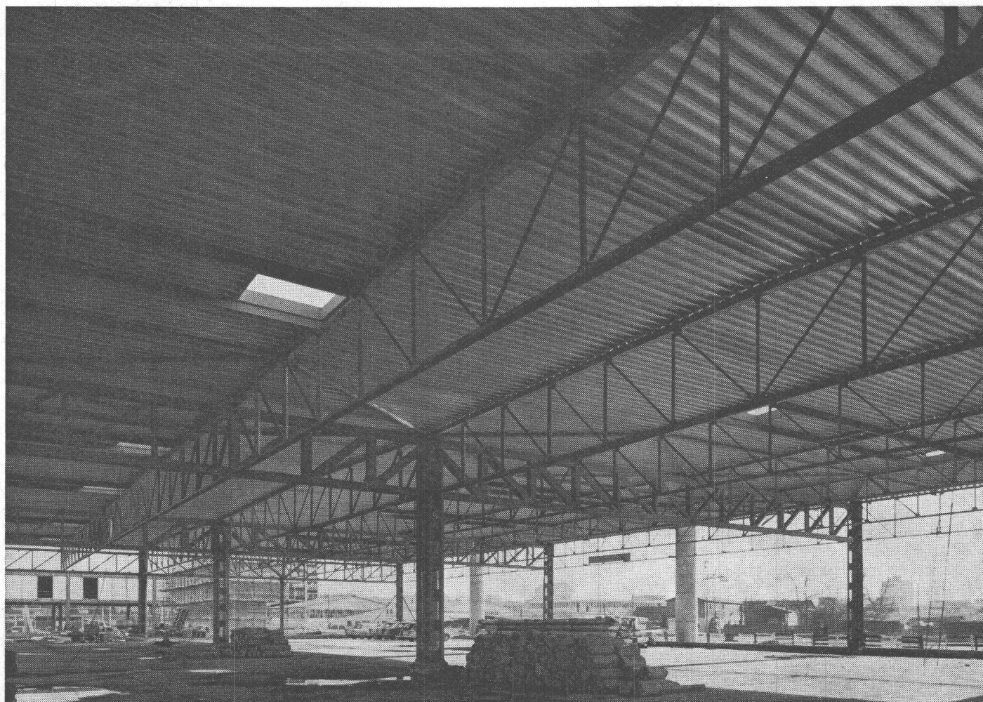
Centre de la voirie des Vernets, Genève. Charpente métallique du hangar, en cours de montage. Architectes : J.-P. Dom, F. Maurice et L. Parmelin. Exécution : Zwahlen & Mayr S. A., Lausanne/Aigle, en collaboration avec une autre entreprise romande.
