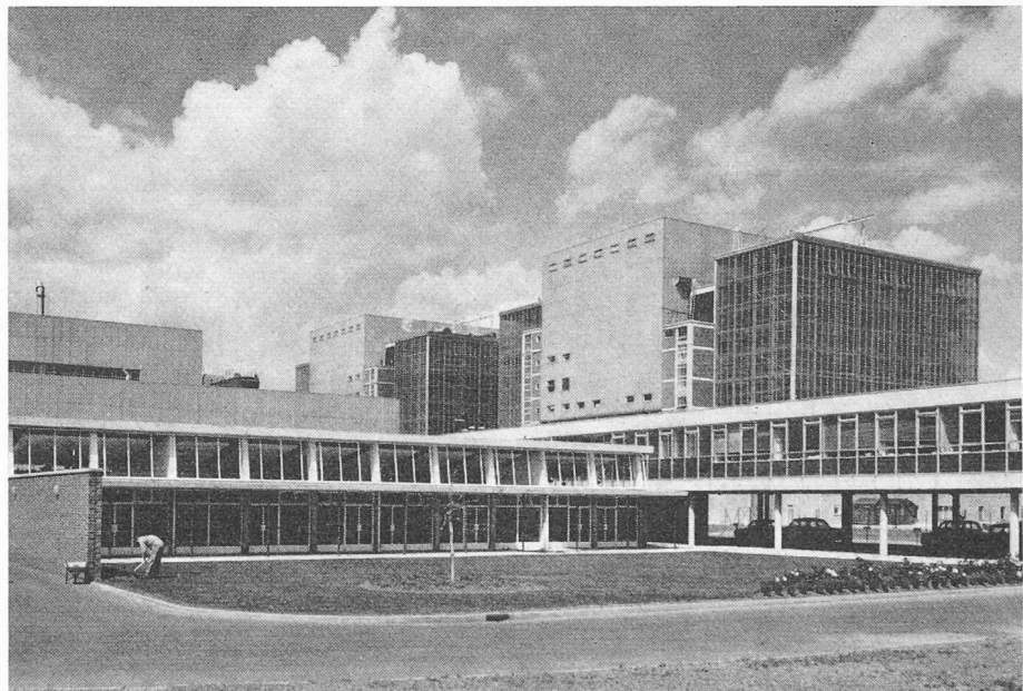
Fig. 8 — Centrale nucléaire anglaise de Bradwell (Essex), comprenant deux réacteurs (dont les bâtiments sont visibles à l'arrière-plan et sont entourés chacun de six échangeurs « in door »). Au premier plan, à gauche, la salle des machines de six turbo-alternateurs. Entrée en service : 1961/62. Puissance électrique totale nette : environ 300 MW.
