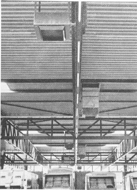
Fig. 3. — Vue partielle du hangar.
