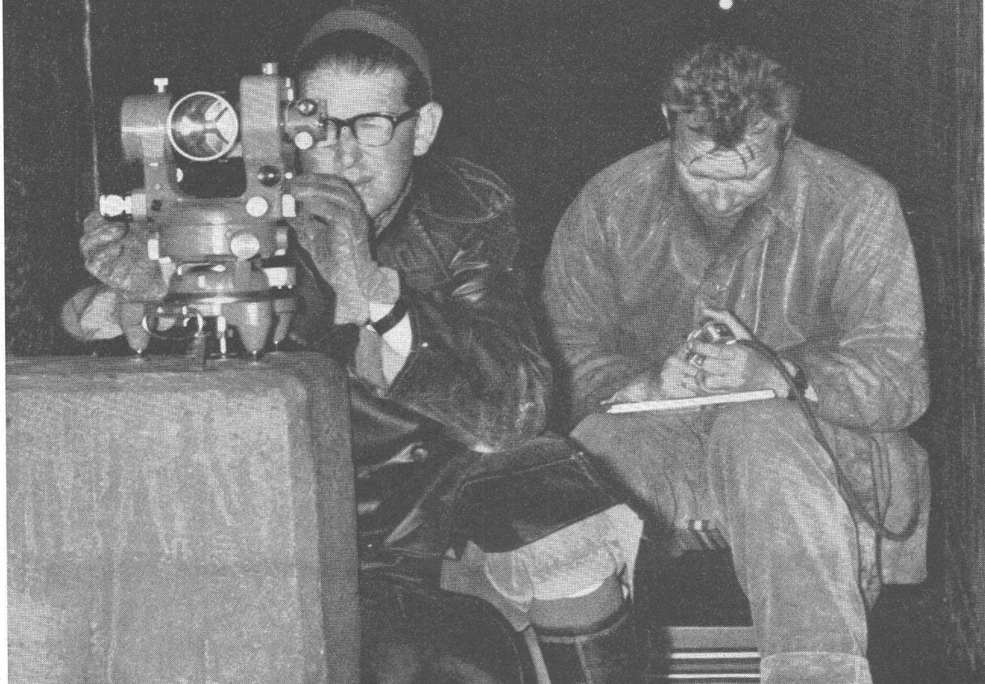
Kern Aarau livre des équipements complets de mesures de précision pour le piquetage, le contrôle et la surveillance d'ouvrages d'art de tout genre. Particulièrement lors de mesures de déformations de barrages et digues des usines hydroélectriques, les instruments Kern jouent un rôle toujours plus important.
