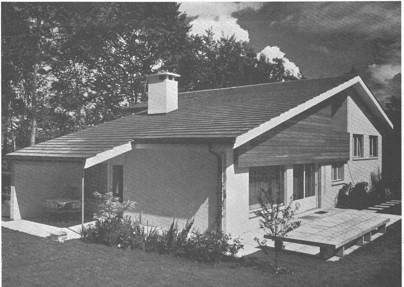
Toiture recouverte de tuiles en béton REDLAND
