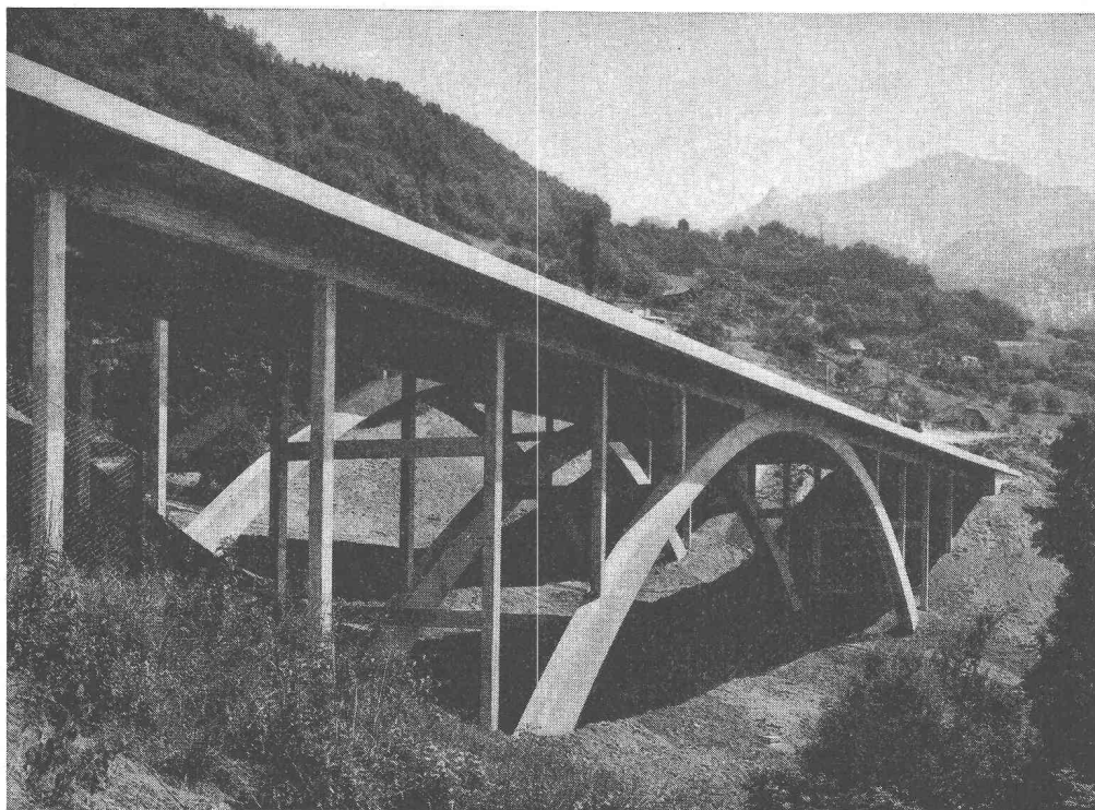
Autoroute du Léman — Pont des Vuarennens, Chernex VD
