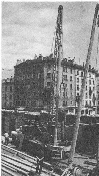
Fig. 9. — Foreuse sur camion.
