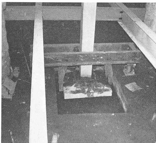
Fig. 4. — Appui d'un poteau métallique.
