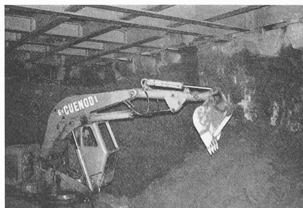
Fig. 16. — Pelle hydraulique sous la charpente.
