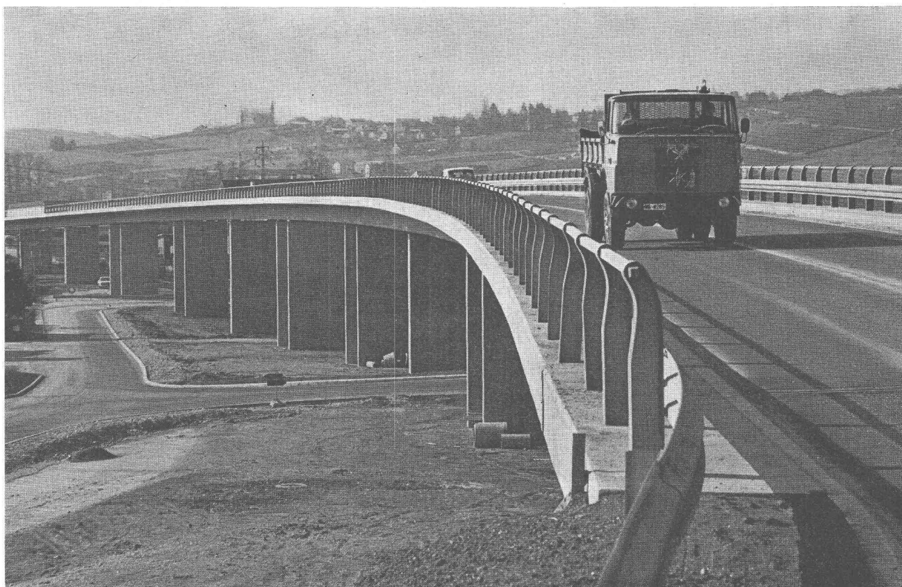
Viaduc de Bussigny
