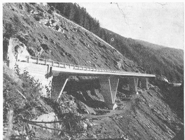
Fig. 1. — Vue d'ensemble de l'ouvrage.
