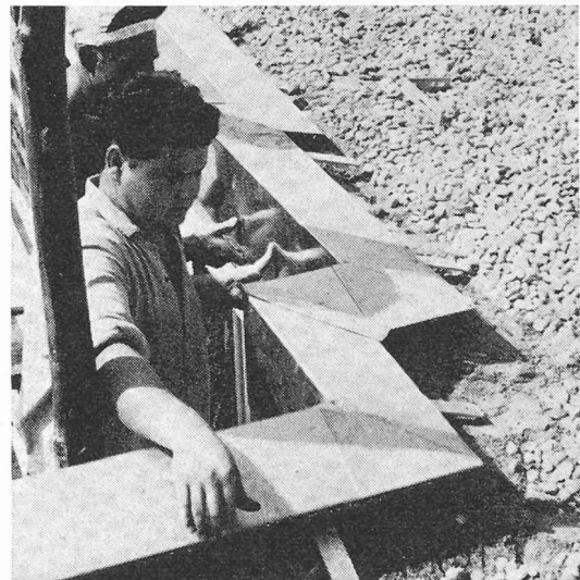
Pose des cornières de support préfabriquées
