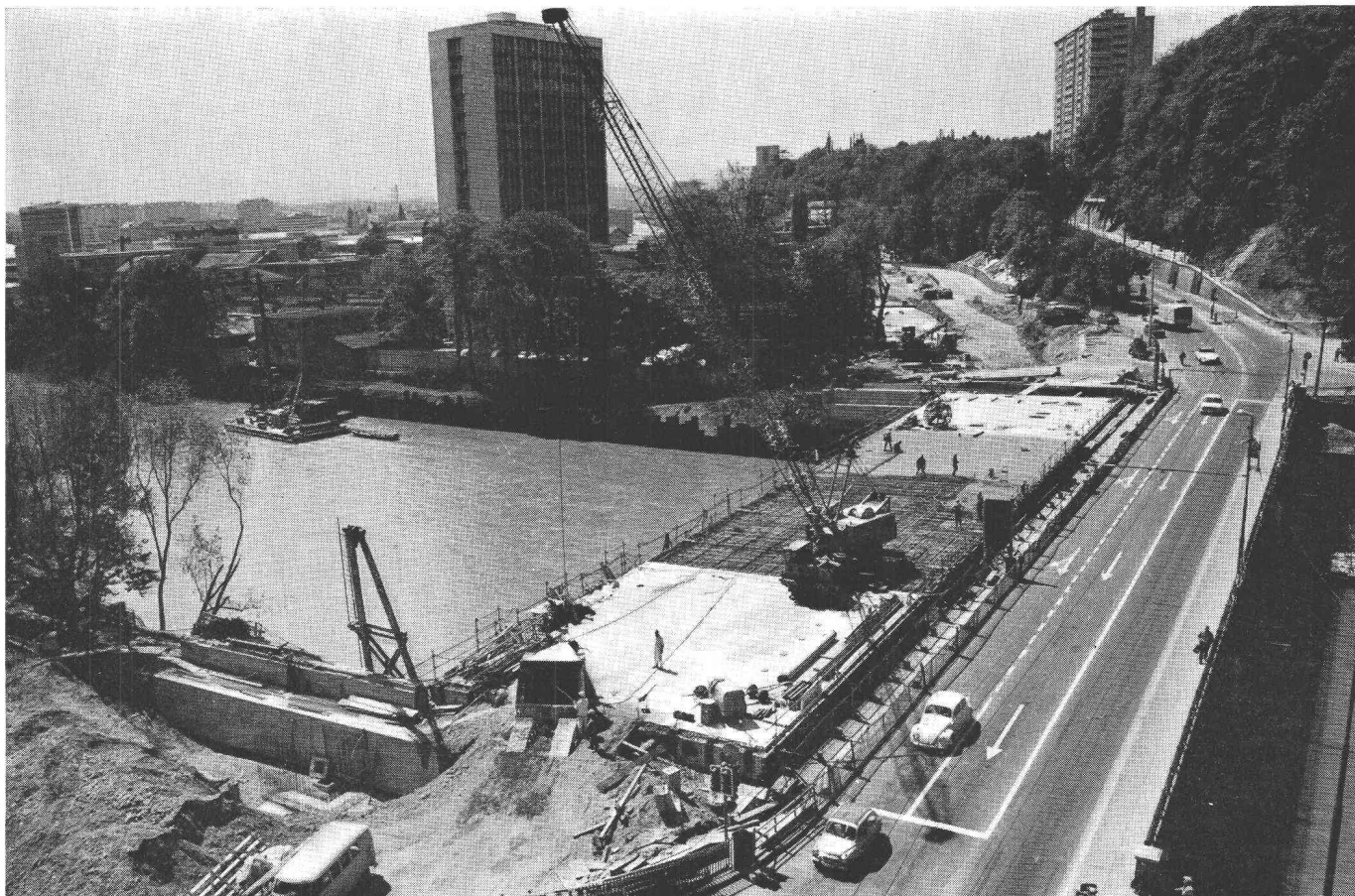
Pont de St-Georges sur l'Arve, Genève Bétonnage du tablier sur éléments préfabriqués
