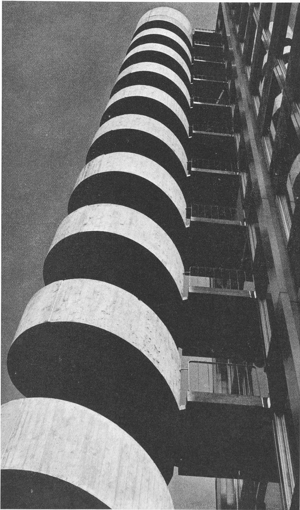
L'escalier de secours sur la façade nord-ouest de la maison SIA
