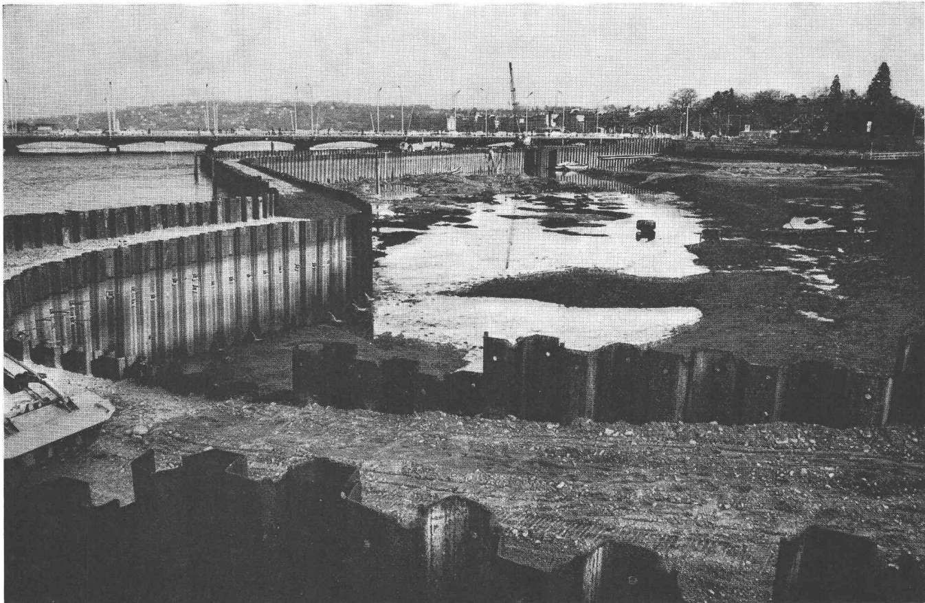
Batardeau pour l'excavation du Parking du Pont du Mont-Blanc, Genève
