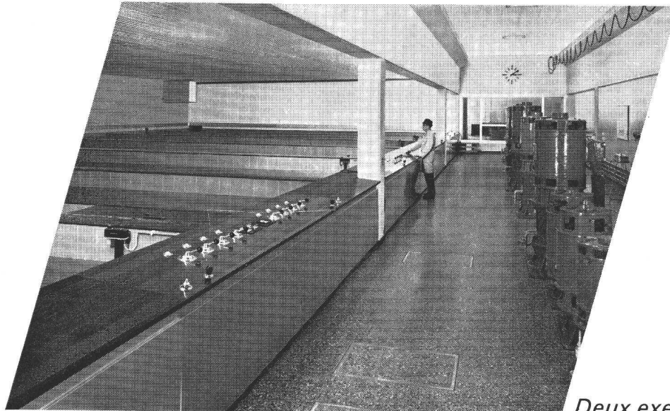
▲ Installation de filtres rapides de Champ-Bougin, appartenant à la ville de Neuchâtel, pour le traitement d'eau du lac en eau potable. Capacité 1800 m 3 /h Pompes de forage Sulzer dans la station de pompage «Hard II» du Service des eaux de Lenzbourg. Chaque unité refoule 150 l/sec à 132 m de hauteur
