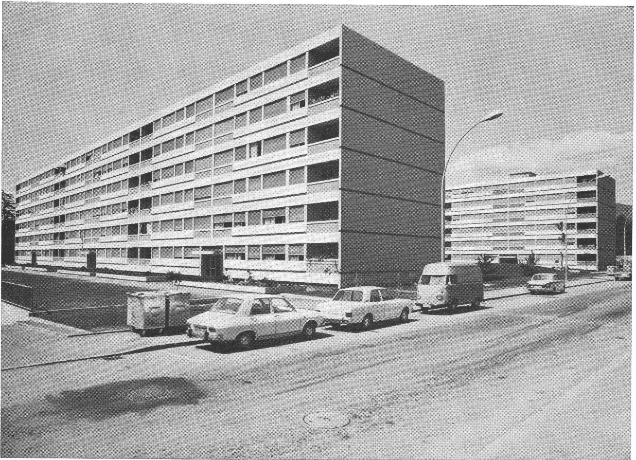
SI Meyrin-Sud, 216 appartements HLM Projet: MM. Hermès & C ie , architectes SIA-AGA, Genève Bureau d'étude S.A. Conrad Zschokke (statique et béton armé) Exécution en entreprise générale 1969/71
