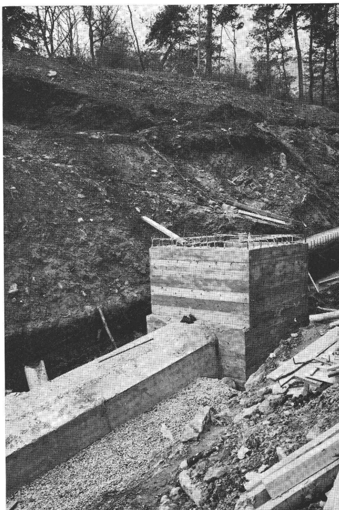
Voûtage du Flon à Tartegnin Emploi des tuyaux en PVC GRESINTEX Ø 1000 mm, comme coffrage perdu.
