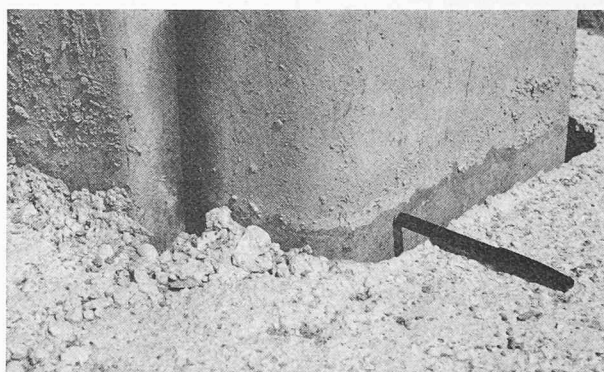
Fig. 4. — Décollage des palplanches.
