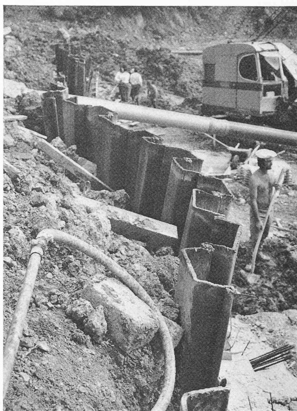
Fig. 3. — Basculement des palplanches. (Photo Germond)
