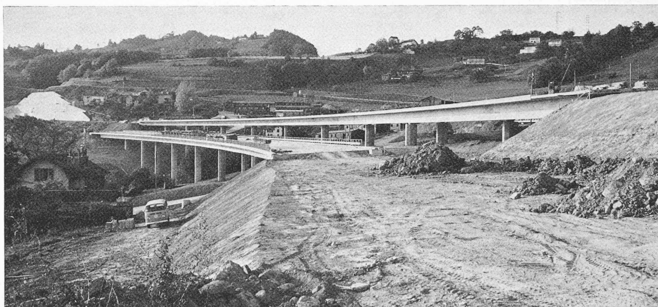
Fig. 6. — Vue de l'ouvrage terminé.
