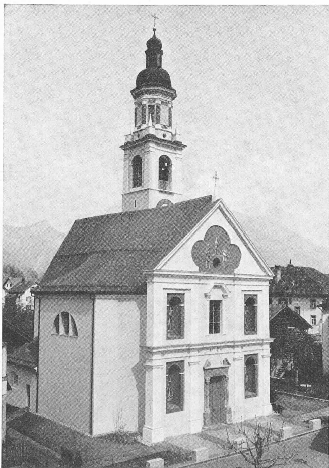
Fig. 9. — Eglise de Rhäzuns. Assèchement électro-osmotique des murs exécuté en 1968. (Photo C. Guler, Thusis.)
