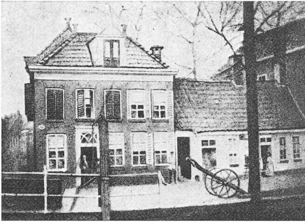
Fig. 5. — Vue prise aux environs de 1850 du « Zuiderdiep » (côté nord) — jonction Pelsterstraat avec la maison « Camphuis ». On remarque les remparts en briques de consolidation des rives, les pavés et les plantations d'arbres ; la rue est bordée d'habitations et d'entrepôts de marchandises pour le transport fluvial.
