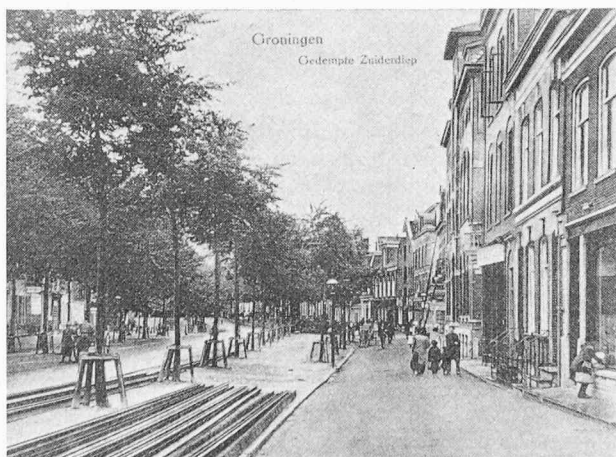
Fig. 13. — Photo des environs de 1910. Mise en place des rails pour le tram électrique, fonction de circulation en augmentation.
