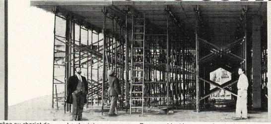
Grâce au chariot de coffrage pour dalle Mills, vous pouvez exécuter des coffrages de dalles avec plusieurs réutilisations, d'une façon simple et rapide.
