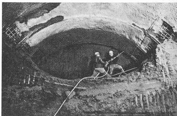
Fig. 10. — Mise en place des ancrages supérieurs dans le terrain.
