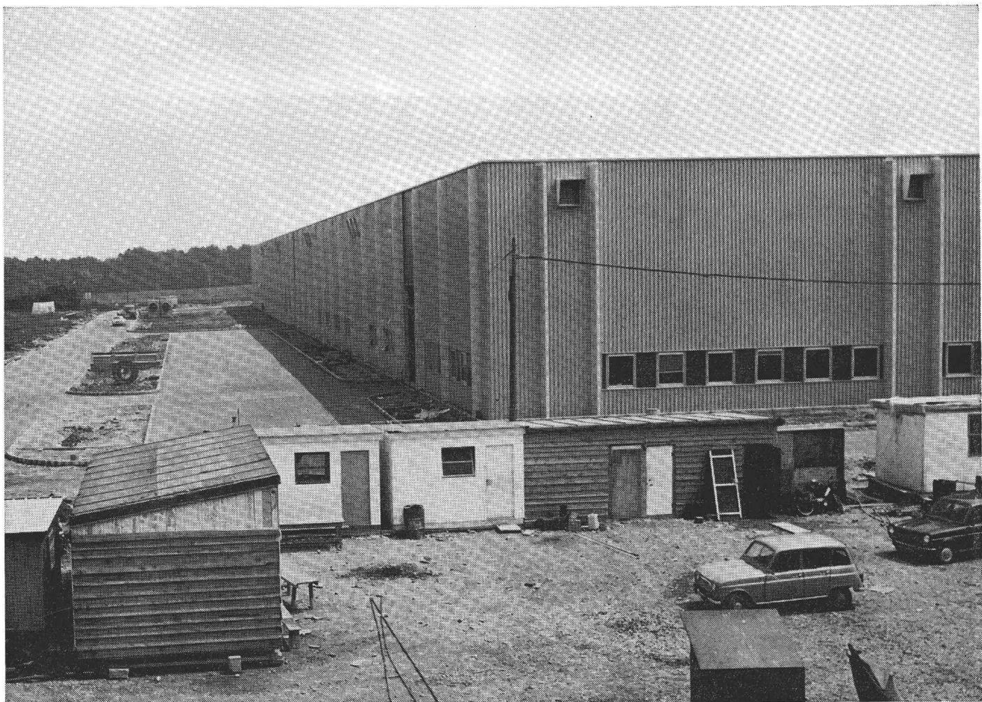
Revêtement de façade et supports toiture en acier nervuré ACIÉROÏD d'une halle de montage au CERN (Centre européen de recherche nucléaire) près de Genève — Surface 20 000 m<sup>2</sup>.
