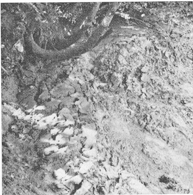
Fig. 17. — Déséquilibre des berges sous l'action du marnage lors de la vidange de 1972.
