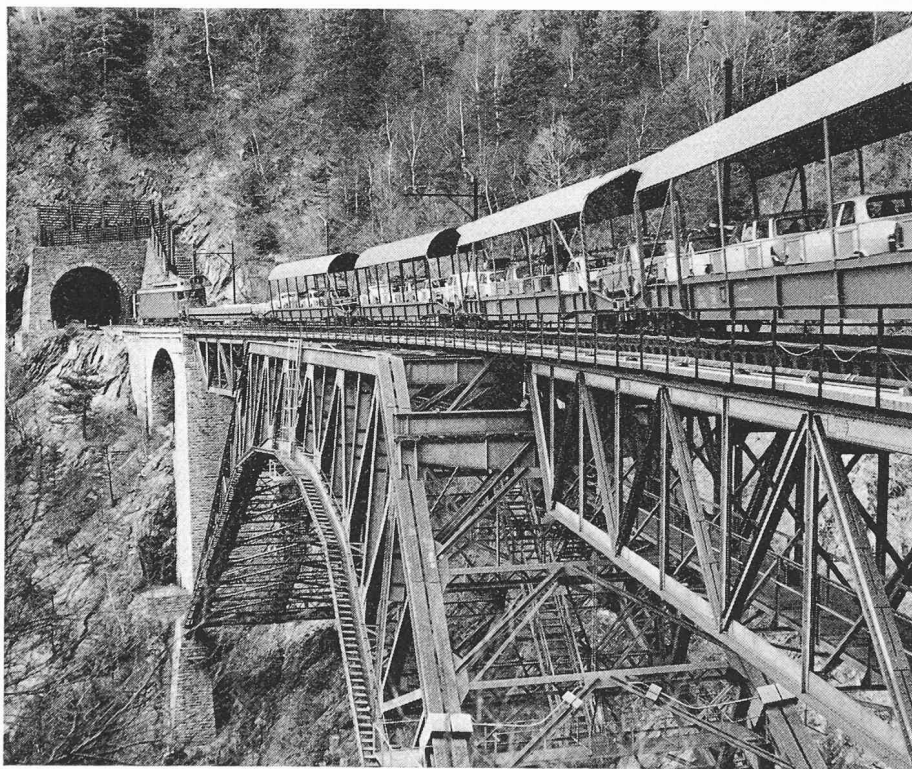
Fig. 19. — Viaduc du Bietschtal sur la rampe sud, avec un transport d'automobiles accompagnées (photo F. Marti/BLS).
