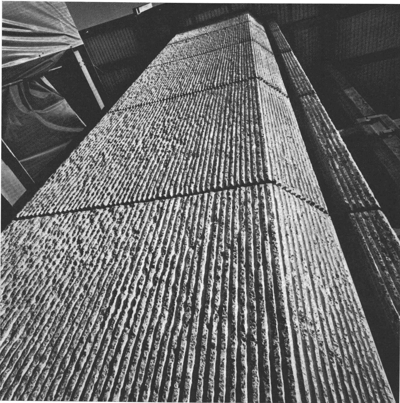
Structure « allergone-cassé », agrandissement de l'aéroport à Kloten-Zürich, 16 tours - ca. 5000 m 2 .
