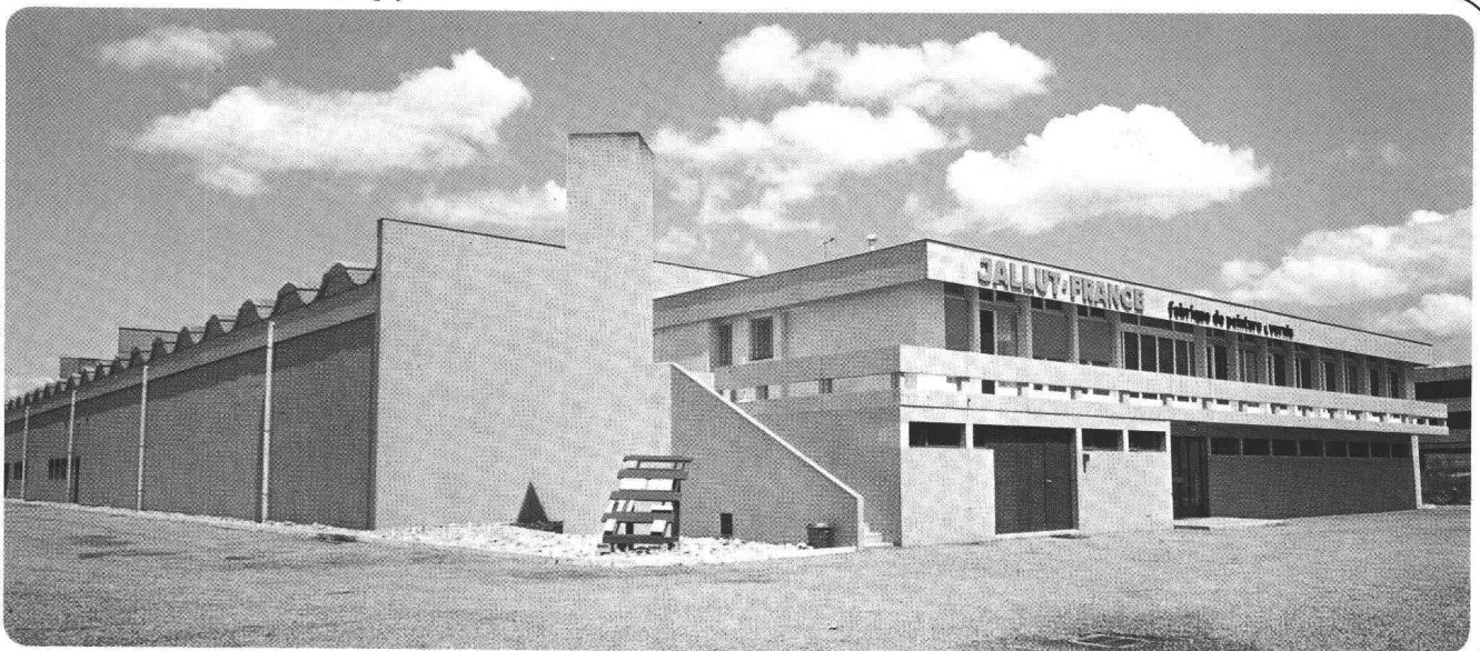
Usine JALLUT-FRANCE S.A., Annemasse
