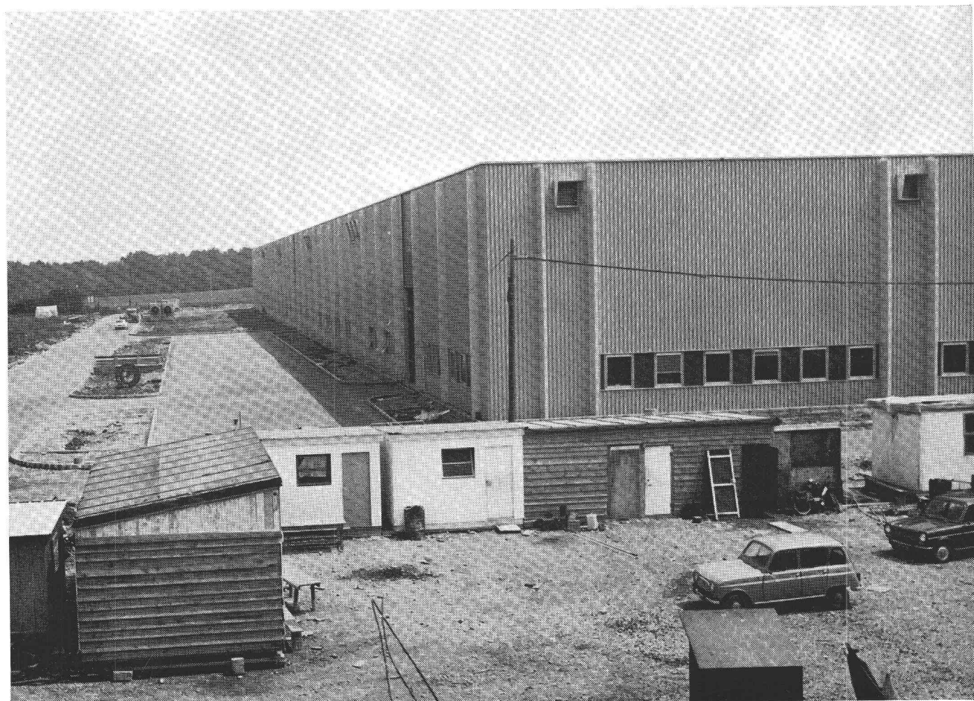
Revêtement de façade et supports toiture en acier nervuré ACIÉROÏD d'une halle de montage au CERN (Centre européen de recherche nucléaire) près de Genève — Surface 20 000 m 2 .
