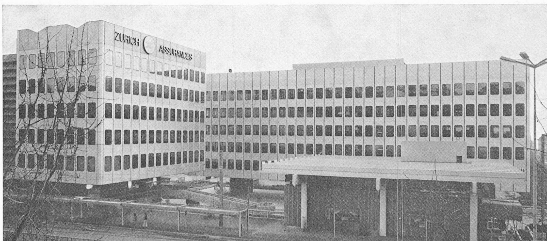
Fig. 11. — Ensemble de la façade nord.
