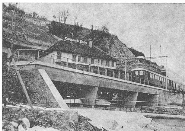
Fig. 106. — Le nouveau pont sur le port d'Alfermée, fondé sur des pieux. A l'arrière-plan, le restaurant « Zur Laube » qui a été démolé lors de la construction du viaduc de la RN 5.
