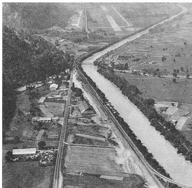
Fig. 176. — Coude du Rhône à Gampel, vu de l'est, au début des travaux.
