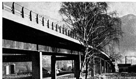
Pont-route au-dessus d'une voie ferroviaire en trafic
