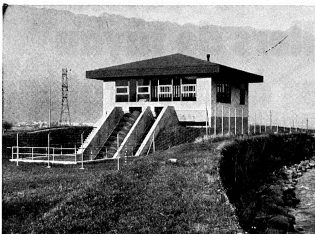
Station de relevage des eaux de décharge de la commune de Wilderswil.
