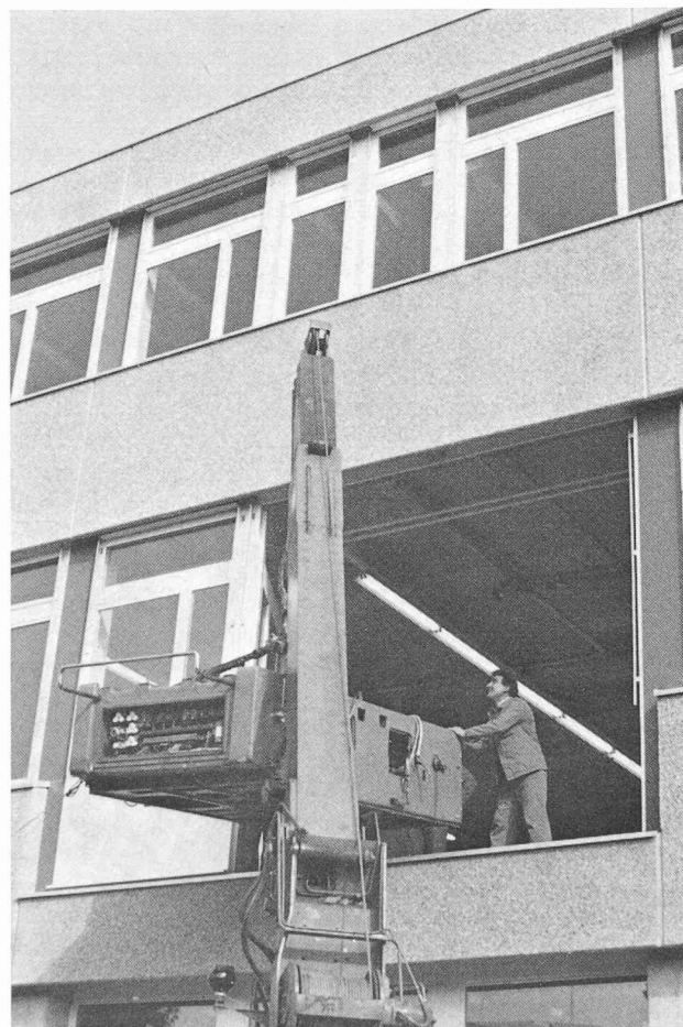
Eléments de façade ouvrants (deuxième niveau), permettant l'introduction des machines les plus encombrantes.
