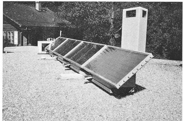
Fig. 2. — Installation des collecteurs sur le toit de la villa.
