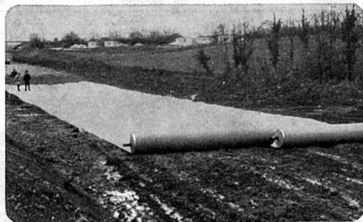
Déroutement de la nappe, apport de grave naturelle à l'avancement
