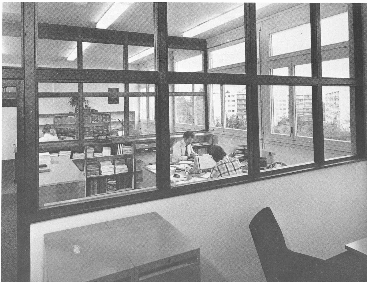
Locaux administratifs. Les cloisons vitrées modulaires, réalisées en acajou, peuvent être déplacées de façon à modifier le compartimentage des locaux en fonction de besoins ultérieurs.
