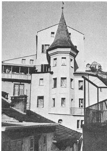
Fig. 1. — Maison de Platea: façade ouest avant la restauration (à gauche).
