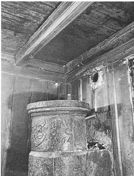
Fig. 7. — Maison de la Lombardie : chambre au fourneau ; détail avant la restauration.
