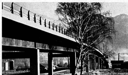
Pont-route au-dessus d'une voie ferroviaire en trafic
