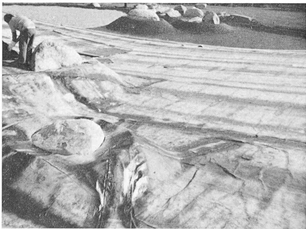
Etanchéification d'un étang à l'école d'horticulture de Lullier (GE).
