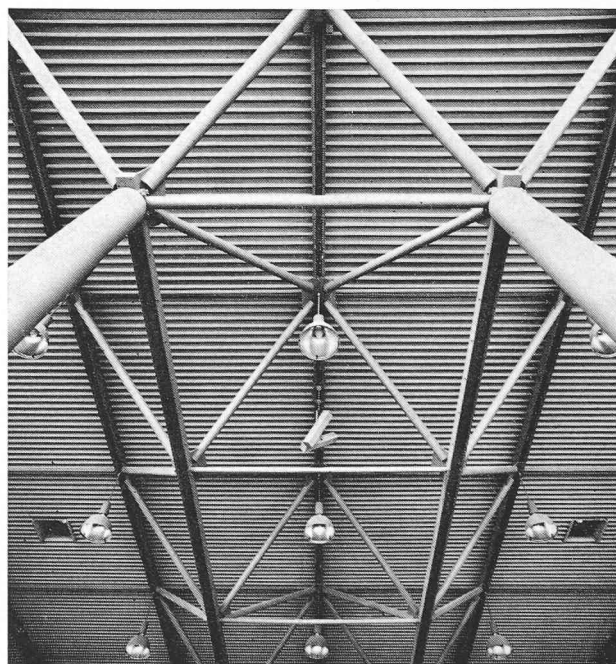
Fig. 5. — Détail d'une poutre en treillis spatial.
