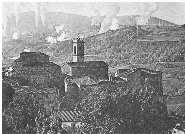
Fig. 1. — Le site géothermique de Larderello, en Toscane.
