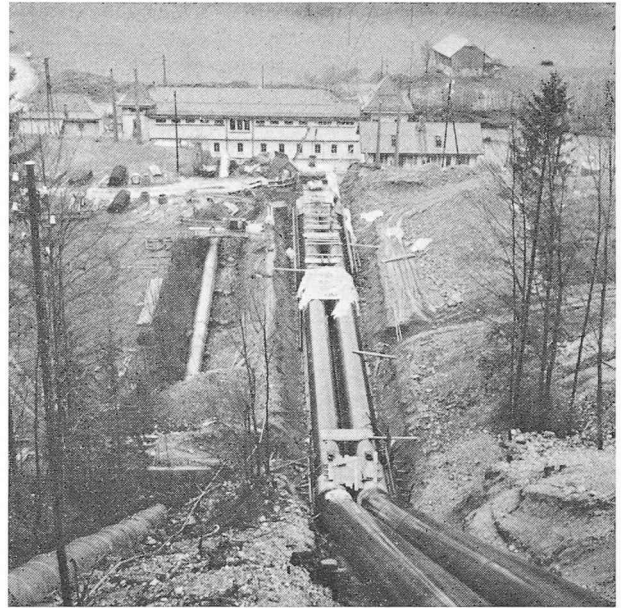
Fig. 14. — Enrobage des conduites forcées.
