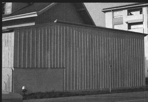
Réfection d'un hangar en bois à Bussigny
