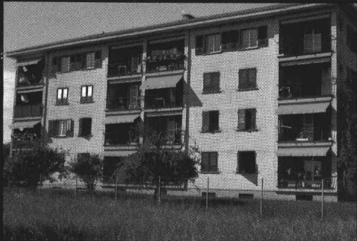
Volets d'immeubles locatifs à Bussigny
