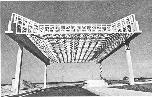
à la presse hydraulique « Compress » et aux connecteurs Gang-Nail standards.
