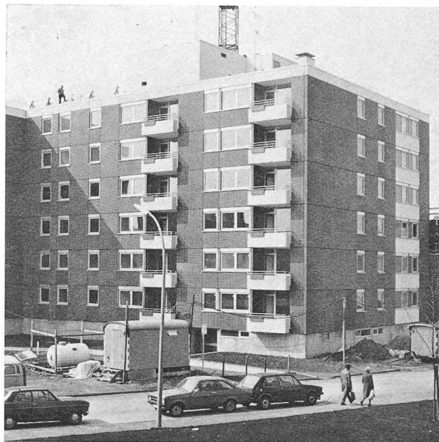
Fig. 1. — Vue extérieure de la maison à 64 appartements à Dortmund pendant la construction. (Photo : Stadtwerke Dortmund.)
