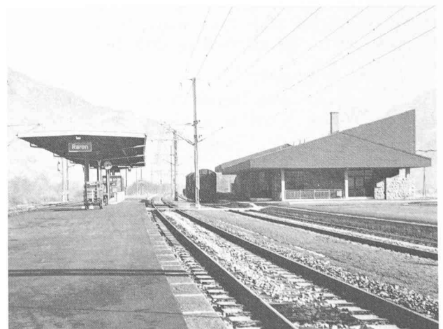
La gare de Rarogne après la rénovation des installations.
