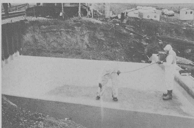
Application de la résine méthacrylate Degadur® sur l'une des deux parties du nouveau pont en béton des Chemins de fer britanniques à Shippea Hill. L'opération s'est effectuée impeccablement et n'a causé aucune difficulté au personnel. On aperçoit, en haut et à gauche, les rails sur lesquels le trafic ferroviaire a continué à circuler en une seule voie sur l'autre moitié du pont.
