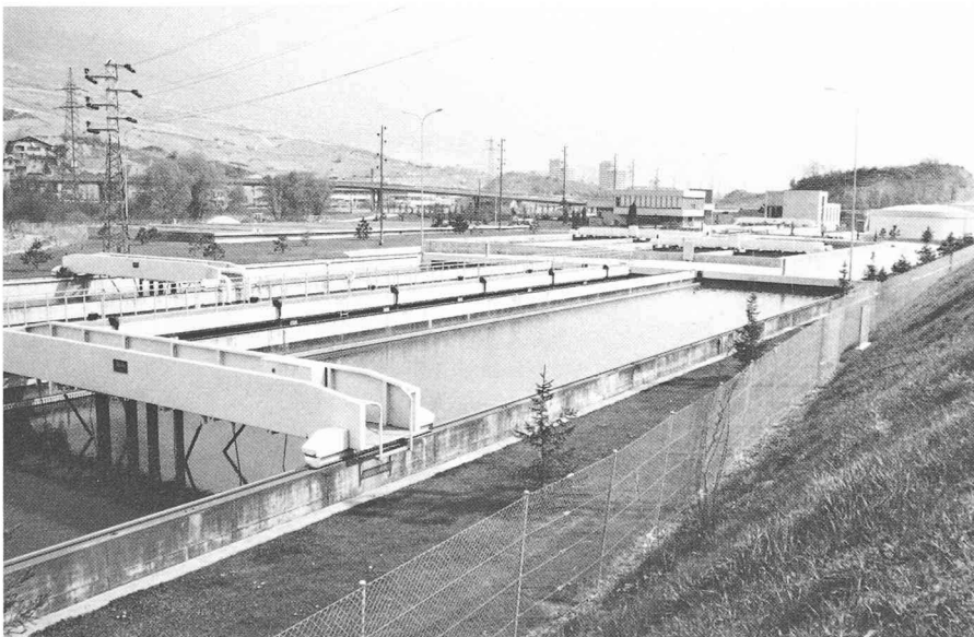
Station d'épuration de Noës/Sierre (60 000 éq./hab.).
